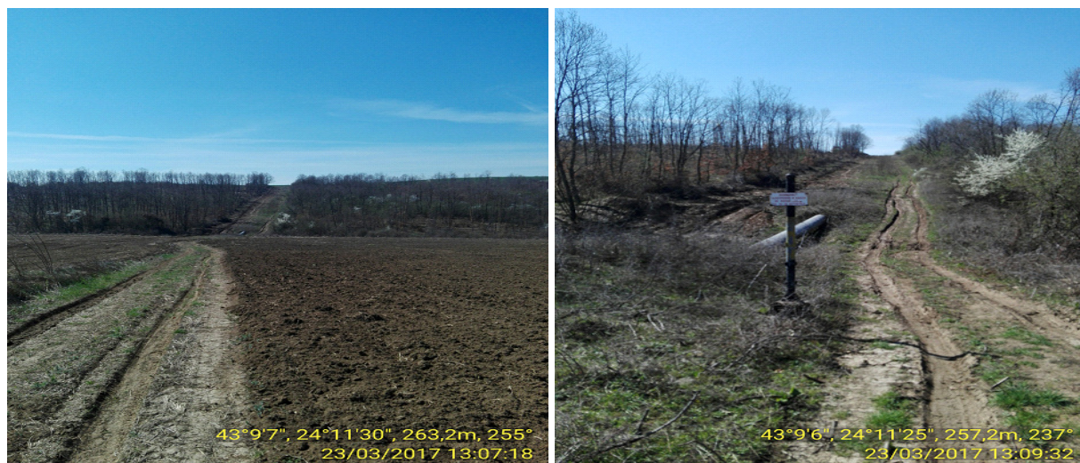
Фигура 3.8.2.1.2-12. Изглед в посока W при прехода на сухо дере в ЗЗ „Карлуково“ – km 24.5
