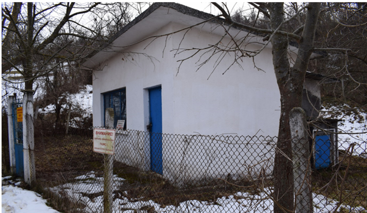
Снимка 16. Резервен водоизточник на с. Беленци - Каптаж „Голямата чешма“ с помпена станция
