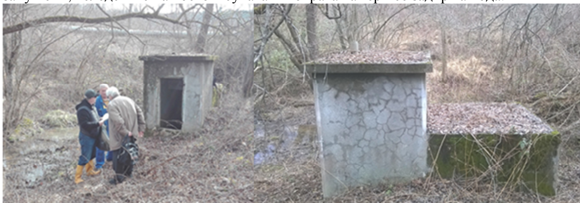
Снимка 1 - Изглед отпред и отстрани на каптаж „Луканова ступла“ с надземния участък на газопровода
